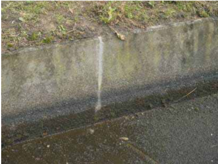
シーリング材による施工
