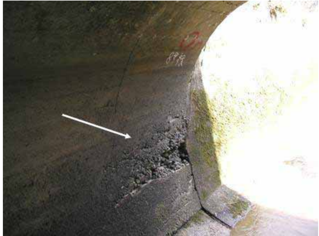
水路トンネル側面
