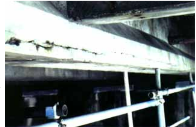
橋桁の損傷
