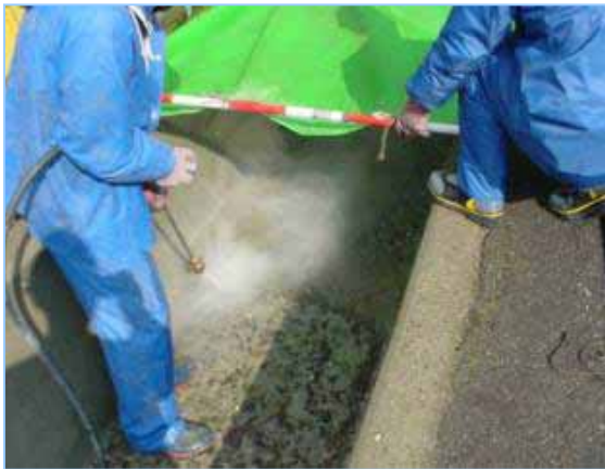
高压洗浄状況
